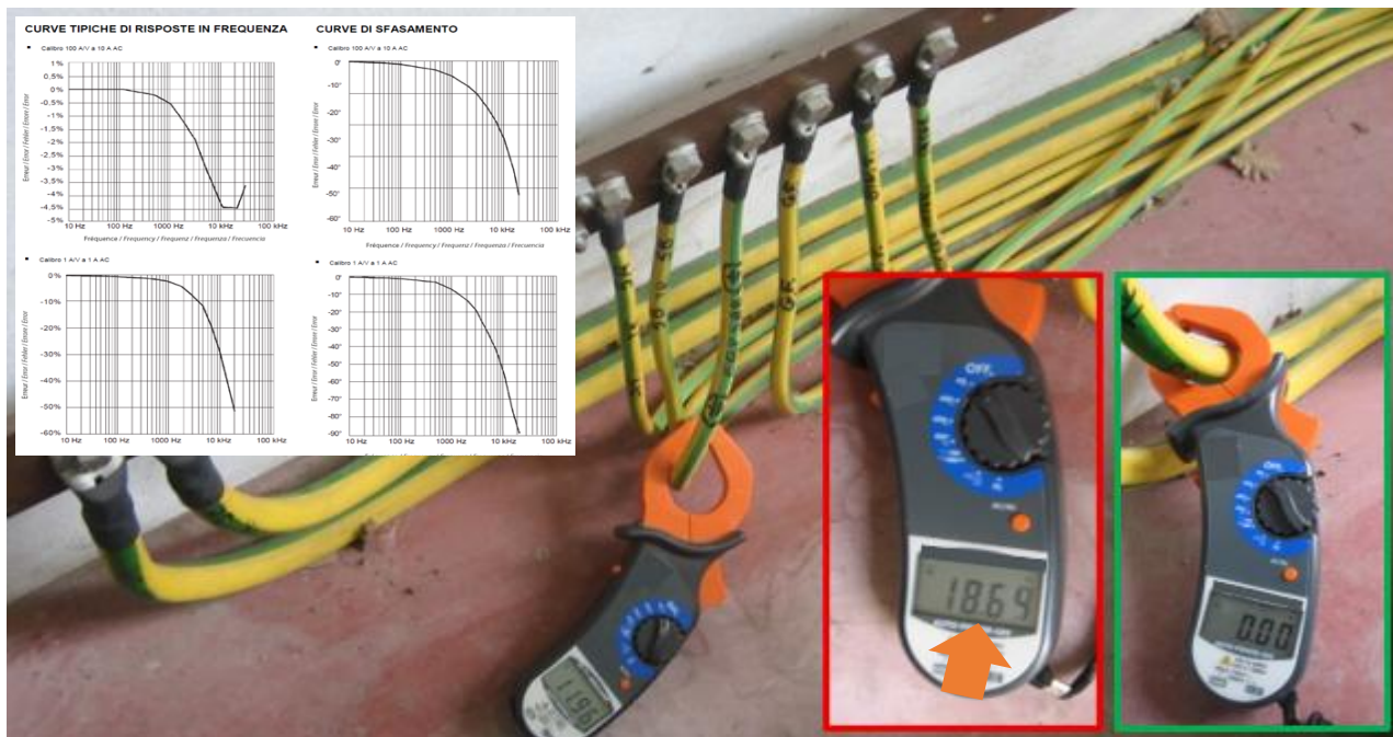
Fig. 7.2.10 – misura delle correnti di dispersione
