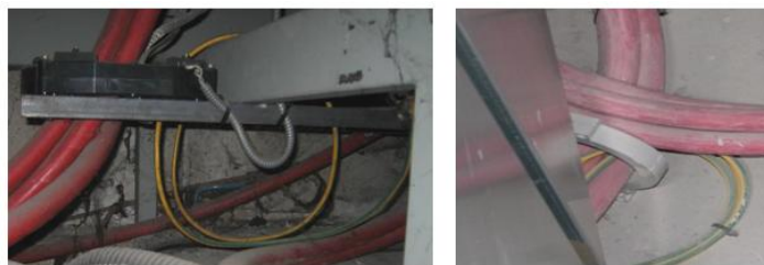
Fig. 7.16.4 – installazione dei trasformatori toroidali
